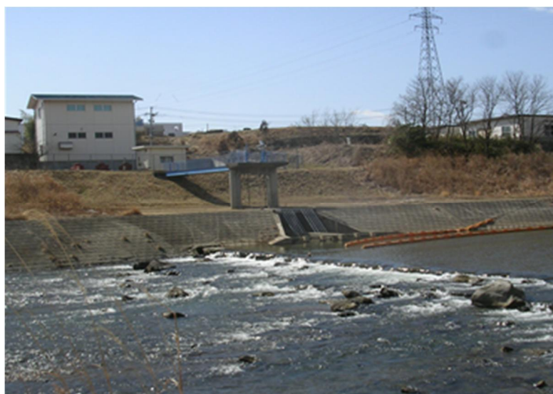
西川浄水場の水源【横山取水場(釈迦堂川表流水)】
