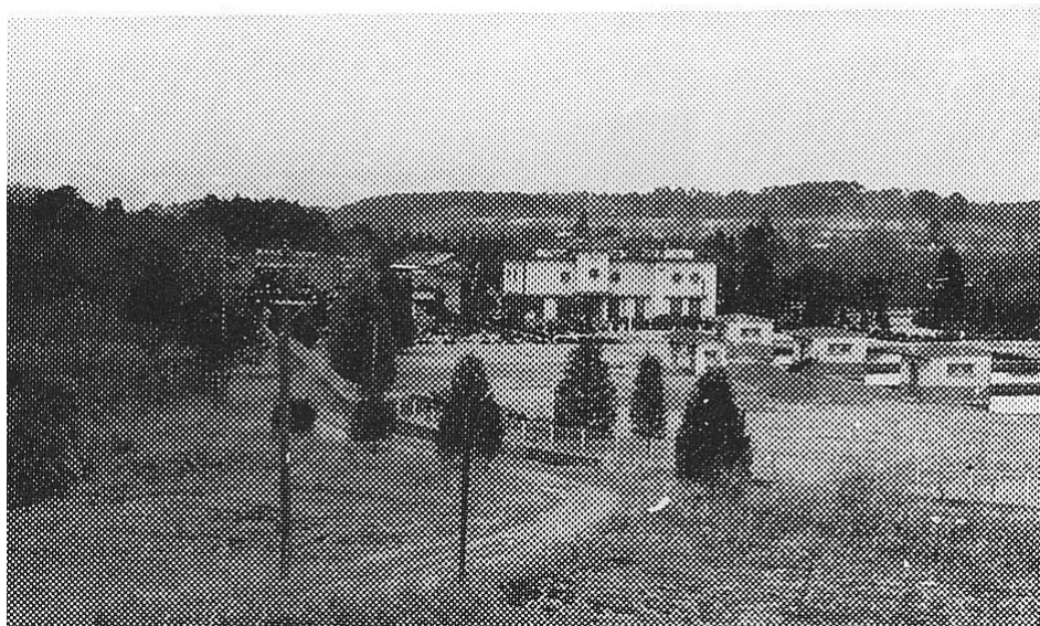
(須賀川市水道事業創設当時の西川浄水場)
